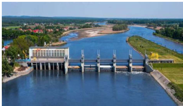
Rys.4 Elektrownia Wały Śląskie [materiały projektu]
