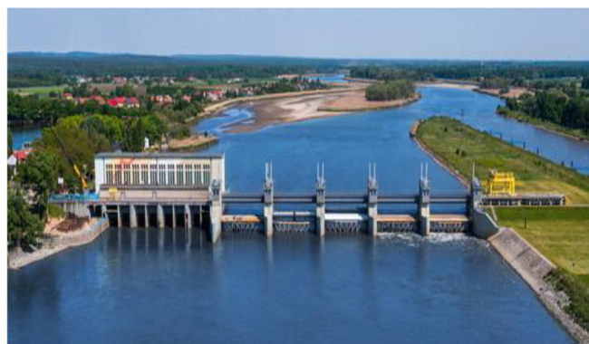
Rys. 5. Elektrownia wodna Wały Śląskie [11]
