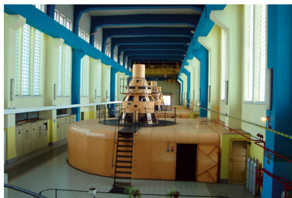
Rys. 6 Hala maszyn elektrowni [11]
